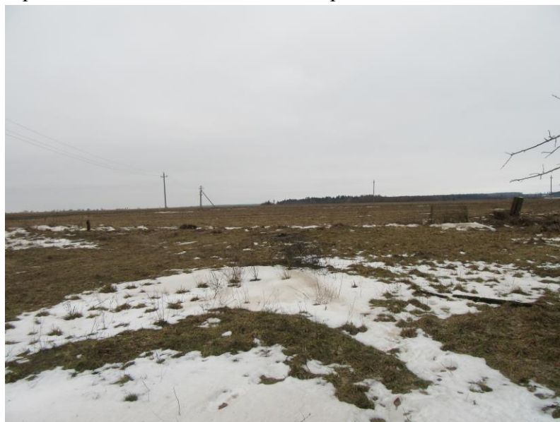
Рисунок 3.1.5.2 – Площадка строительно-монтажных работ
